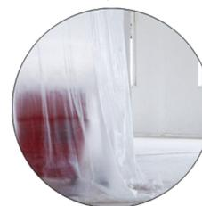
Las cortinas se dividen en dos tipos: Visuales y acústicas. Las primeras serán de PVC reciclado con cierto grado de transparencia. Las segundas además constarán de una franja de tejido acústico reciclado para amortiguar el sonido
